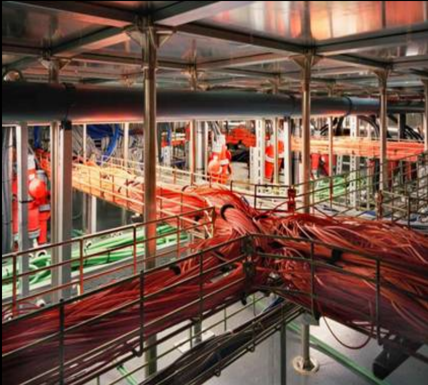
MareNostrum ~5K fiber cables
